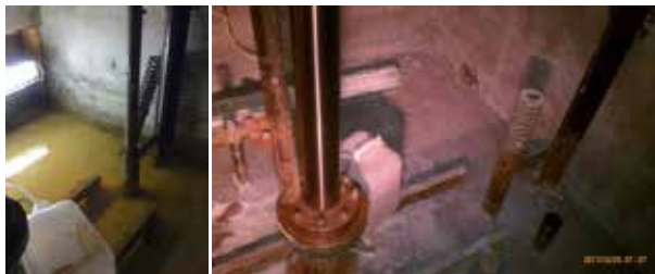
Imágenes del foso de elevador antes y después de la aplicación del impermeabilizante por cristalización
